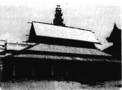
ရွေတိုက်ဆောင် (တည်ဆောက်ဆဲ)
