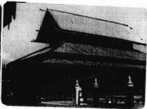
လက်ဖက်ရည်ဆောင် (တည်ဆောက်ဆဲ)
