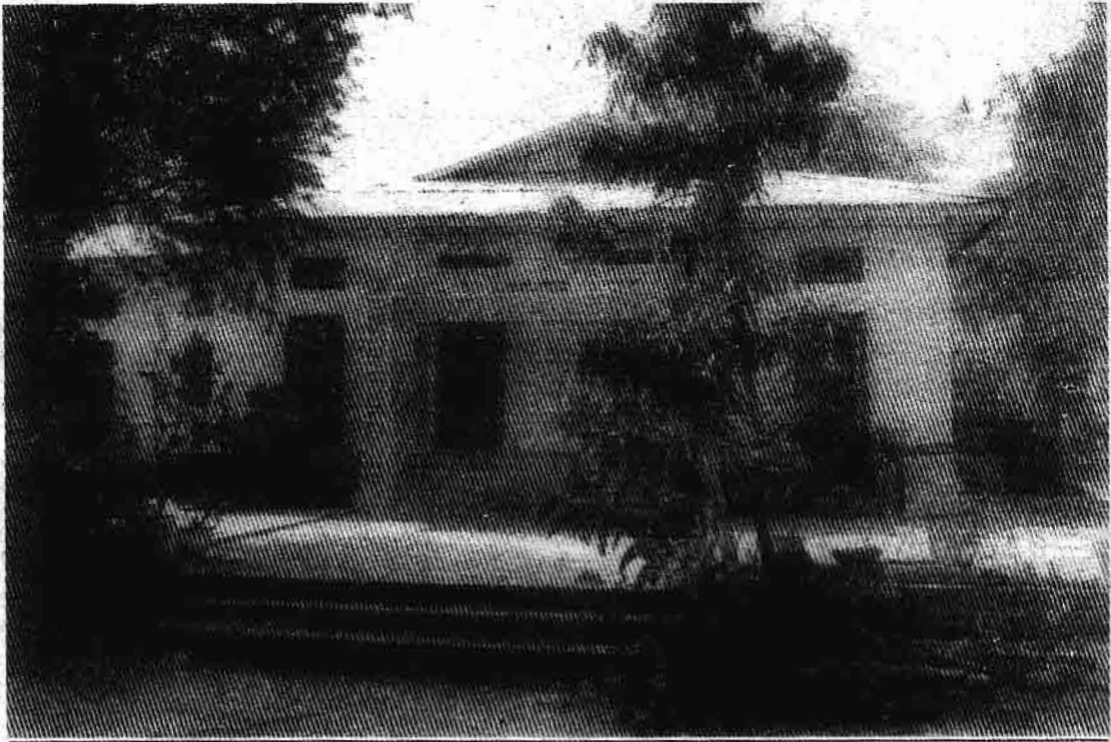
ယခင် ဆွမ်းတားကျောင်းတော်မှာ ခြောက်ငါးရက်ခန့်သာ ဆောက်လုပ်လျှင်ဆိုသော ခြောက်ကျောင်း
