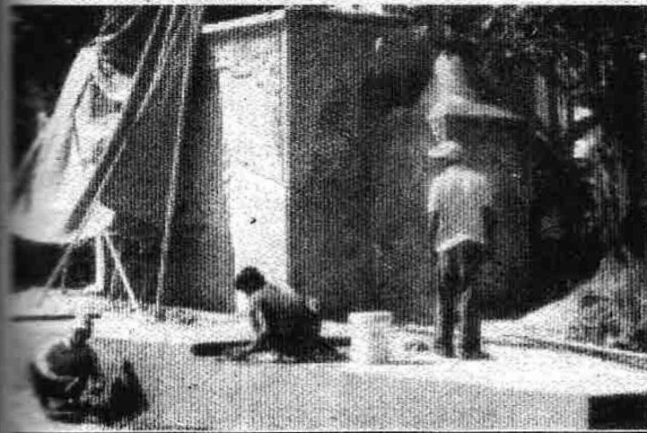
ဆောက်လုပ်ဆဲ ထာရစ် ဝူကျောင်း
