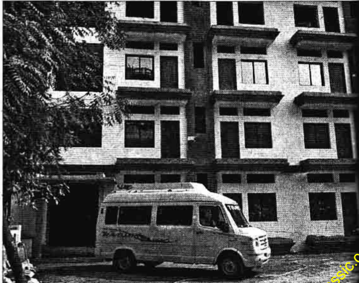
ဗာရာဏသီ ဆေးဝက်ဘာမြန်မာကျောင်းက လေးထပ်တည်းခိုဆောင်
