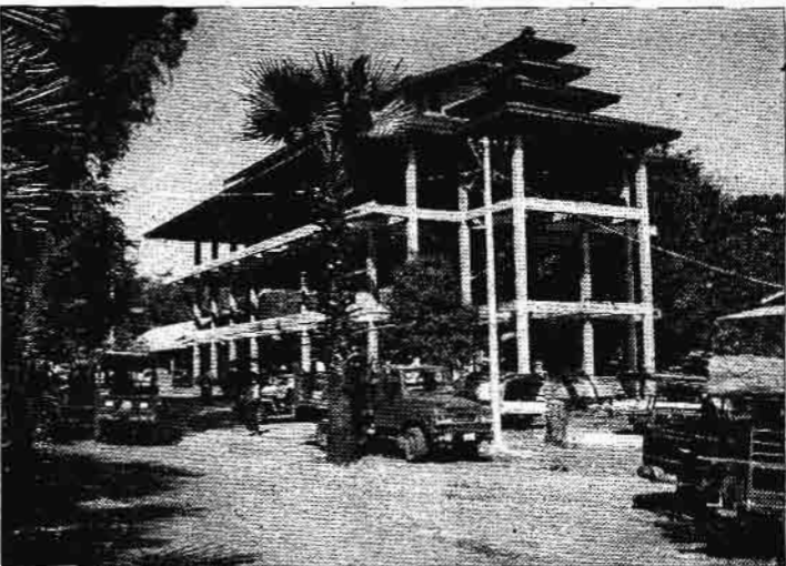
တောင်ပီလာတောရအတွင်း ဆောက်လုပ်နေဆဲ သုံးထပ်ဆွမ်းစားကျောင်းဆောင်ကြီး
