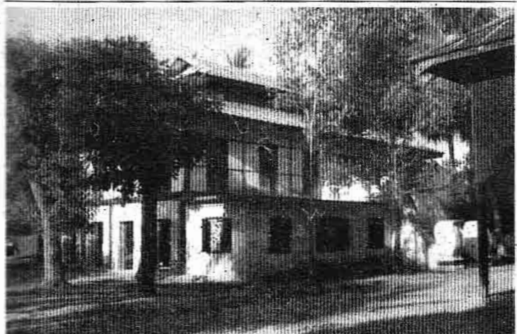
▼ ဂဟန်းထွေးများကျောင်းဆောင်
