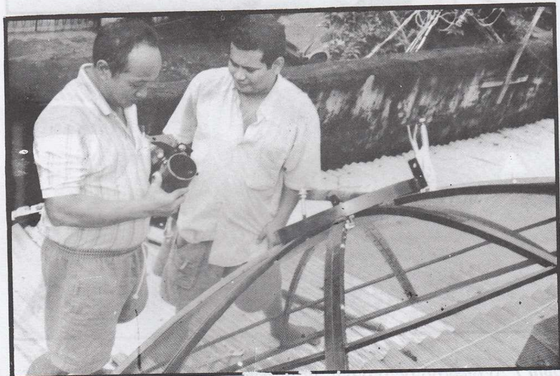
[ Mount ] သံဘီးခွေတပ်ဆင်ပြီးနောက် ဇက်ပိုက်အထိုင်တပ်ဆင်ရန်ပြင်ဆင်နေပုံ
