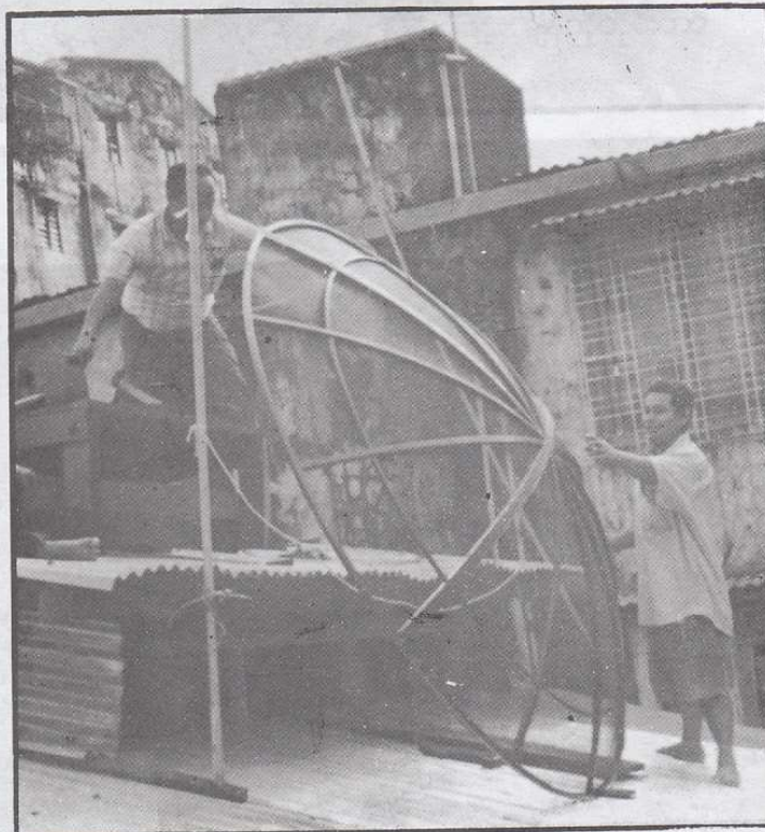
Dish Antenna အရွက်(၄)ခြမ်း တွဲဘက်ပြီးမြင်တွေ့ရပုံ
