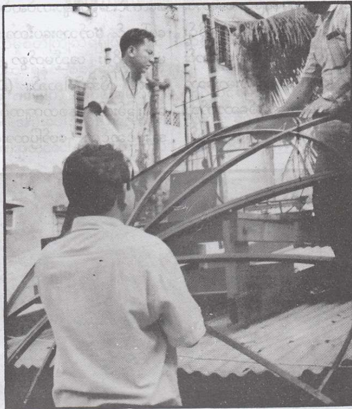
Dish Antenna အရွက် (၄)ခြမ်း တွဲဘက်နေပုံ
