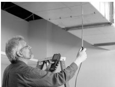
ပုံ ၅-၂၁ Duct test holes
