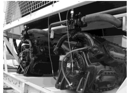
ပုံ ၁၃-၄၉ Semi hermetic reciprocating compressor
