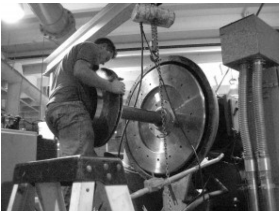
ပုံ ၂၁-၁၅ Centrifugal chiller overhaul
