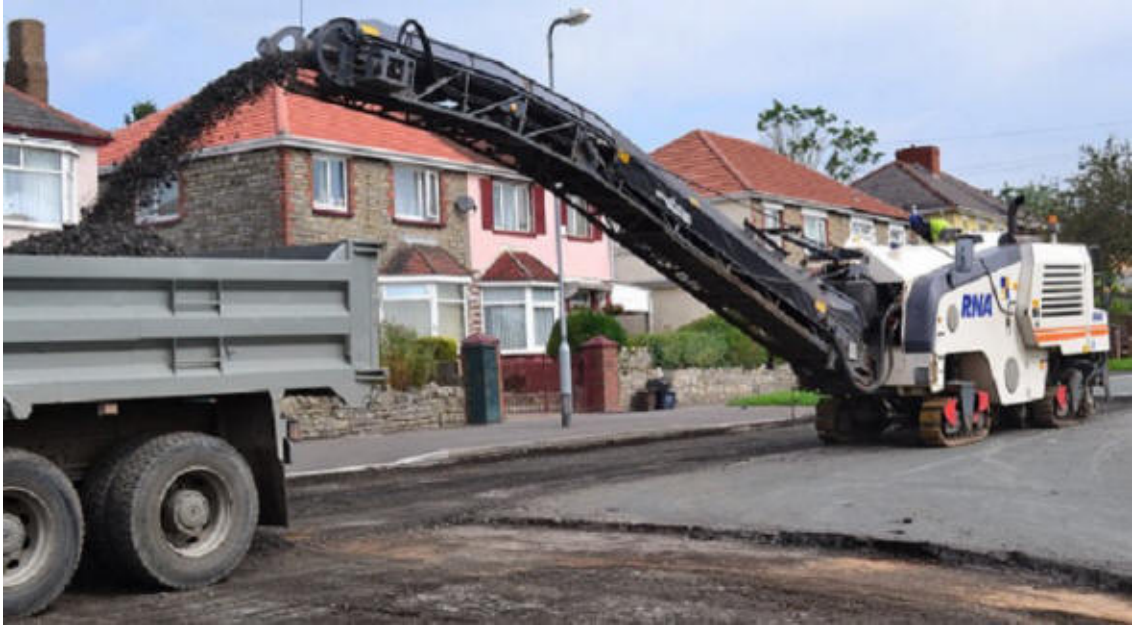
ပုံ(2.18) Asphalt Milling Machine အလုပ်လုပ်ပုံ
