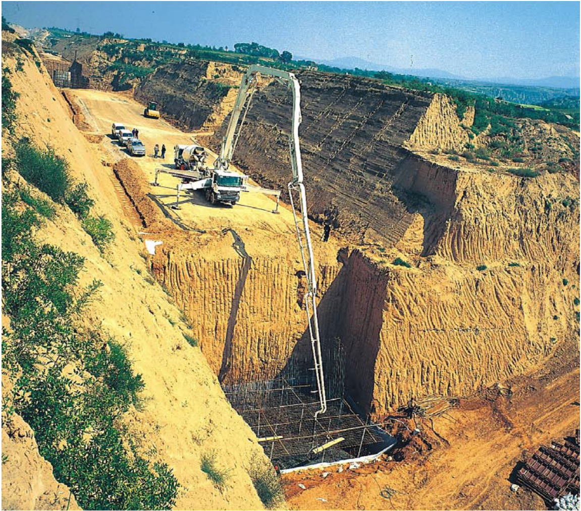
ပုံ(1.8) Boom Pump ဖြင့် ကွန်ကရစ်လောင်းနေပုံ
