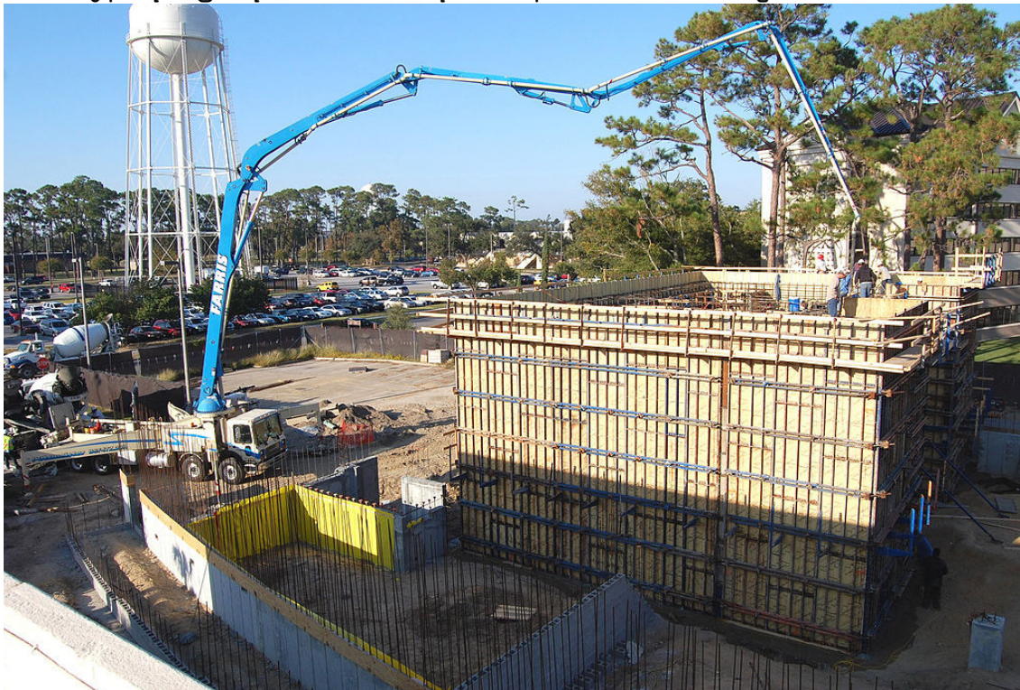
ပုံ(1.5) Truck-Mounted Concrete Boom Pump ကိုအသုံးပြုပြီး Concrete လောင်းနေပုံ
