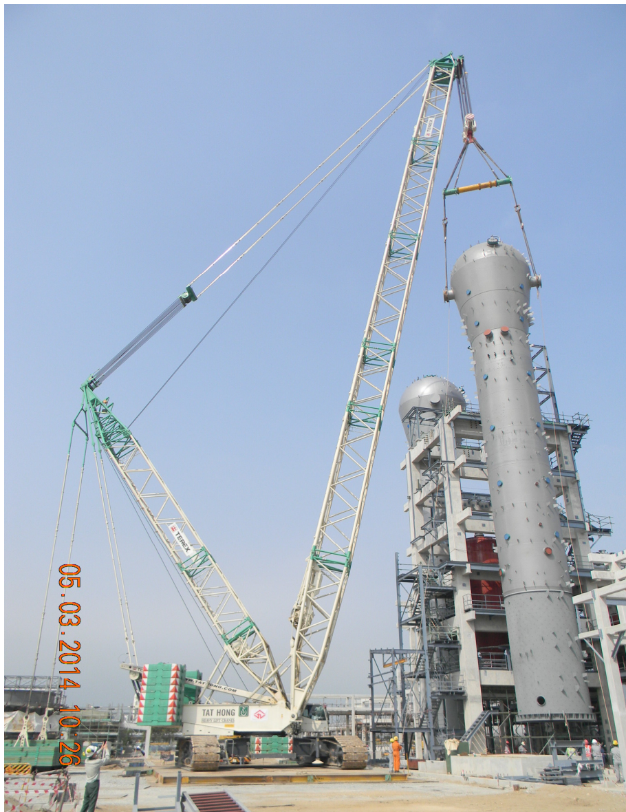
CC 2800-1 (600 Ton) Crawler Crane ပုံ
