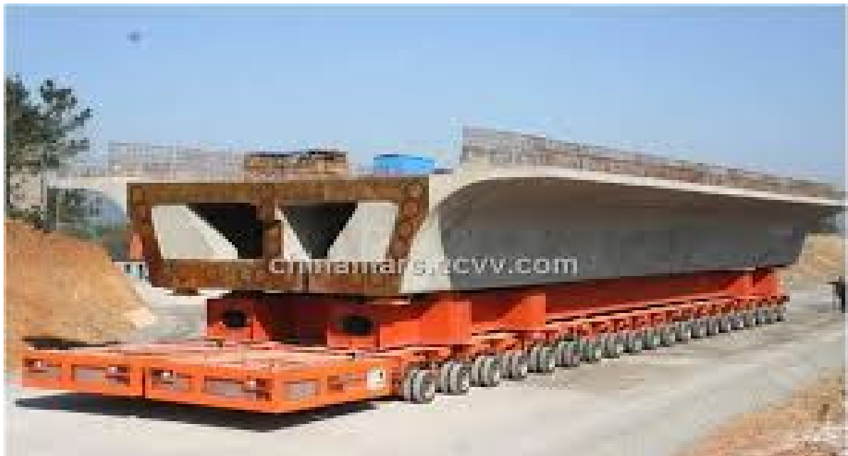
ပုံ(၂.၉) SPMT အသုံးပြုပြီး သယ်ယူပို့ဆောင်ခြင်း
