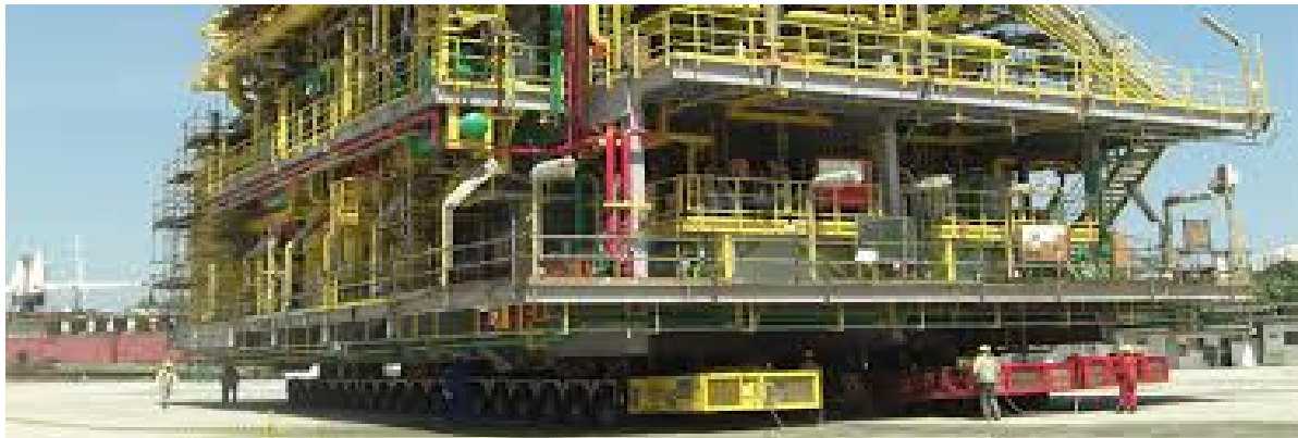
ပုံ(၂.၈) SPMT အသုံးပြုပြီး သယ်ယူပို့ဆောင်ခြင်း
