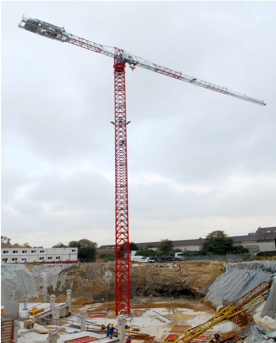
ပုံ(၅.၁) တာဝါကရိန်းကို ဂရော့ဂျက်အစတွင် တည်ဆောက်ထားပုံ
