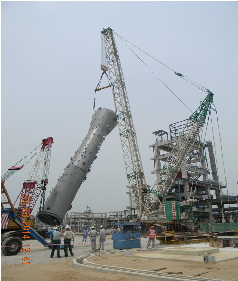
ပုံ(၂.၁၂) Hydraulic Crane အသုံးပြုပြီး တပ်ဆင်ခြင်း
