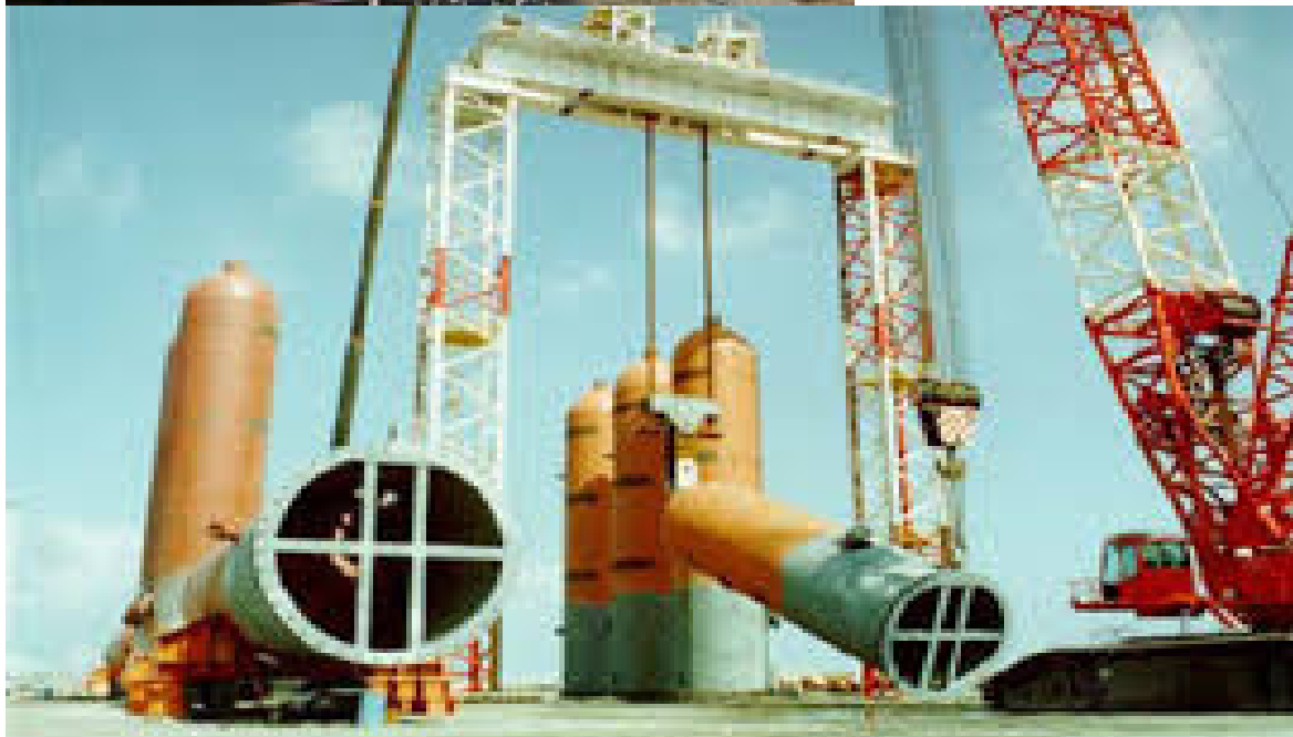
ပုံ(၂.၁၄) jacking system အသုံးပြုပြီး တပ်ဆင်ခြင်း
