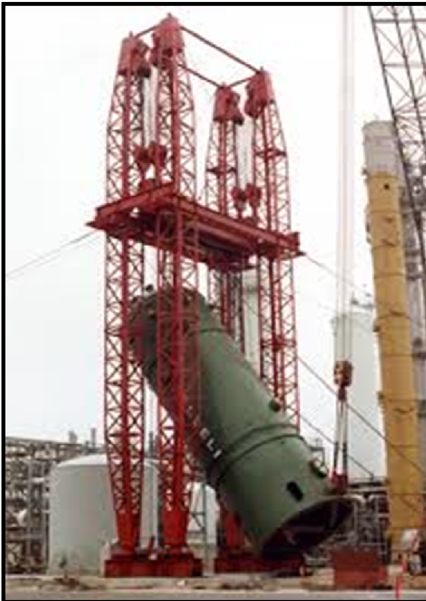
ပုံ(၂.၁၃) Gin pole အသုံးပြုပြီး တပ်ဆင်ခြင်း
