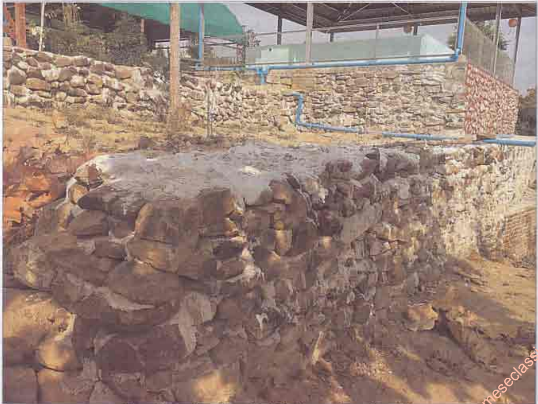
မြေအောက်မှတူးဖော်ရသည့်ကျောက်များဖြင့်တည်ထားသည့်ကျောက်ရေကန်ကြီး
