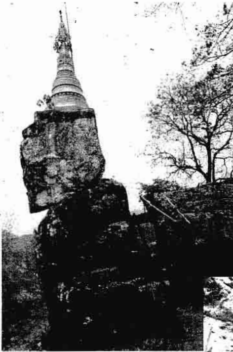
ကျိုက်ထီးရိုးလေးကျောက်တံတိုင်း အောက်ဆံကျောက်တံတိုင်း အကျောက်ရှိ အက်အွဲကြောင်း
