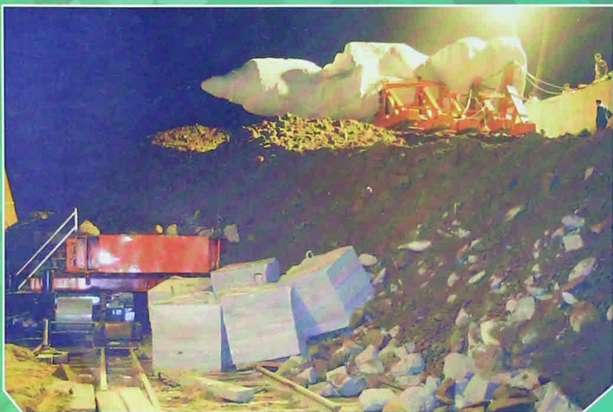
ရုပ်ပွားတော်မြတ်ကြီးကို ပင့်ဆောင်ပြီး ထူမတ်ရန် တန်၄၀၀ ဂျက်များဖြင့် ပင့်မြှောက်၍ သစ်သားတုံးများ၊ ကွန်ကရစ်တုံးများ၊ မြေသားများ ခုခံဆောင်ရွက်ခြင်းလုပ်ငန်း များကို ဆောင်ရွက်စဉ်
