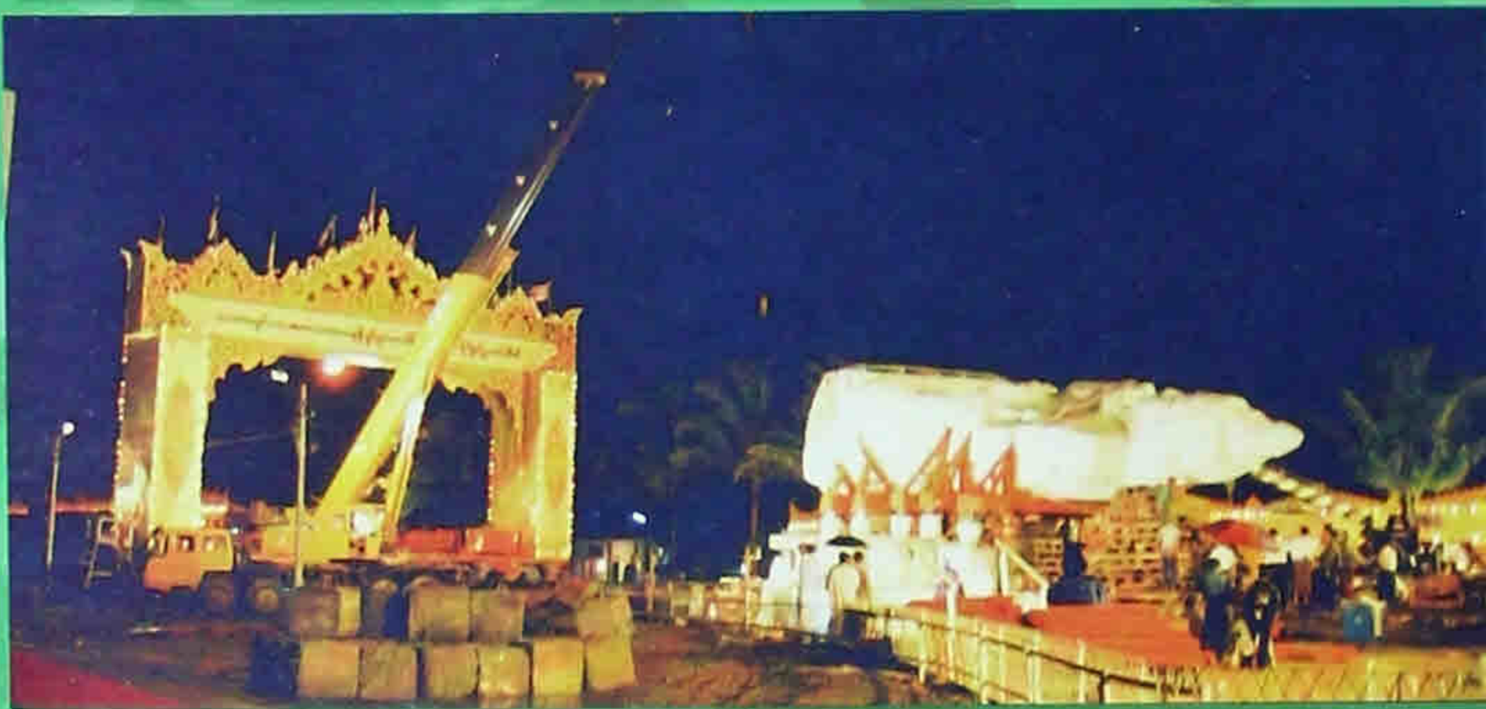
ရပ်ပွားတော်မြတ်ကြီးအား ကြိုကုန်းဆိပ်ကမ်း ရတနာဖောင်တော်ပေါ်မှ နတ်ပန်းရထားပေါ်သို့ ပင့်ဆောင်ရန် တန် ၄၀၀ ဂျက်များဖြင့် မြှောက်ရွှေ့၍ သစ်သားတုံးများ၊ ကွန်ကရစ်တုံးများ ကြိမ်ဖန်များစွာ ခုခြင်၊ မြှောက်ခြင်းဖြင့် နတ်ပန်းရထားပေါ်သို့ ပြောင်းရွှေ့ပင့်ဆောင်စဉ် (၈ - ၈ - ၂၀၀၀)
