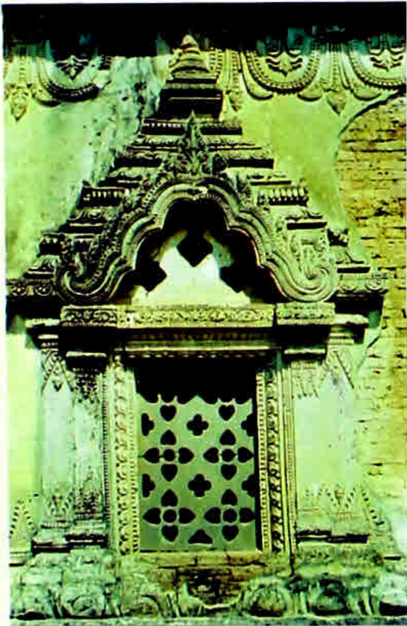
မြင်းကပါ ဂူပြောက်ကြီးဘုရား တောင်ဘက် ပြတင်းပေါက်ပုံ၊ ပြတင်းမှာ ကျောက်ပြား နှစ်ချပ် စပ်၍ အပေါက်များထွင်းဖောက်ထား သည်။ ၎င်းအထက်တွင် ဂူဘုရားအငယ်စား ပုံ တည်ဆောက်၍ အင်္ဂတေပန်းများဖြင့် တန်ဆာ ဆင်ထားသည်။
