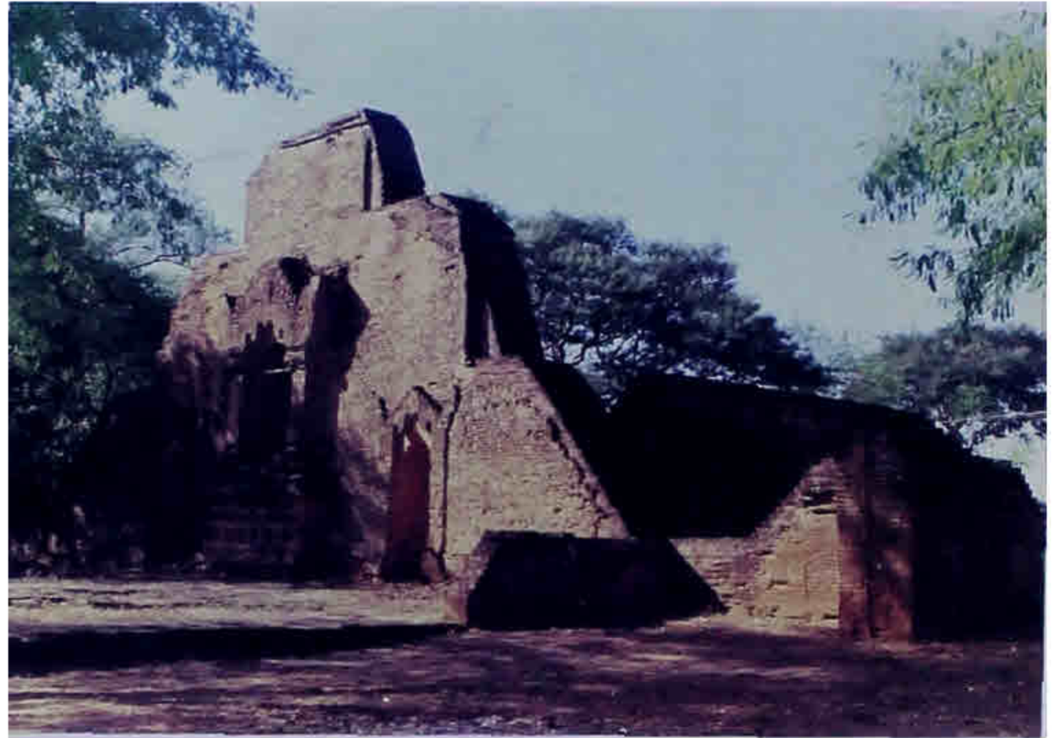
ရှင်အရဟံအုတ်ကျောင်းတည်ဆောက်ထားပုံအနေအထားကို တွေ့ရပုံ
