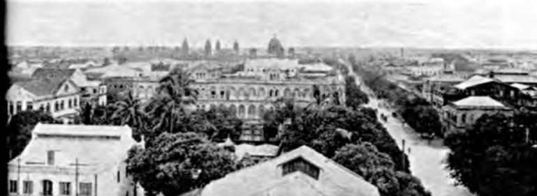
ရိုးကုမ္ပဏီ မျှော်စင်(ယခု ဧရာဝတီဘက်ရုံးချုပ်)ပေါ်မှ ဆီးပြီး မြင်ရသော ရန်ကုန် အရှေ့ဘက်ခြမ်း မြင်ကွင်း
