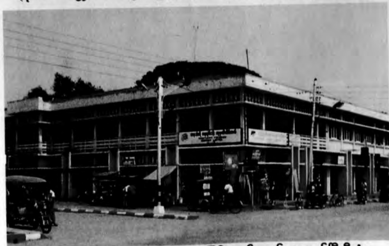
ထားဝယ်မြို့ မင်္ဂလာဈေးသစ်ကြီး ပြန်လည်တည်ဆောက်ပြီးစီးပုံ။
