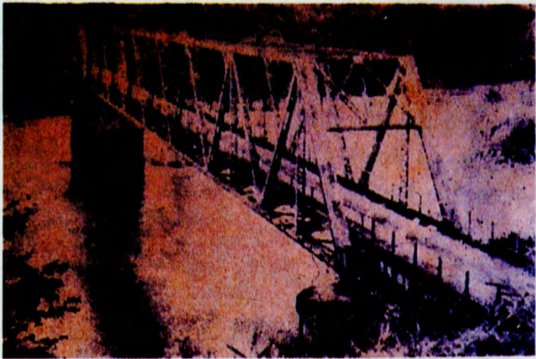
ဒုတိယကမ္ဘာစစ်ကြီးမဖြစ်မီ တည်ဆောက်ပြီးစီးခဲ့သော တနင်္သာရီတိုင်း ထားဝယ်ခရိုင်၏ အကြီးဆုံးနှင့် အလှဆုံး ထားဝယ်-ရေး ကားလမ်း “ကလိန်အောင်တံတားကြီး” ပုံ
